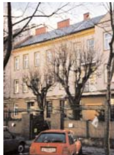
Nach dem Abriss dieses Gebäudes in der Hietzinger Hauptstraße 103 darf "Raiffeisen Leasing" gemäß § 69 um 1,5 Meter höher bauen.
