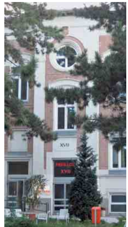
Bald neues Leben in den alten Pavillons...
