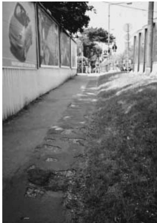
Sanierungsbedürftig – Belag im Abschnitt östlich der Stampfergasse
